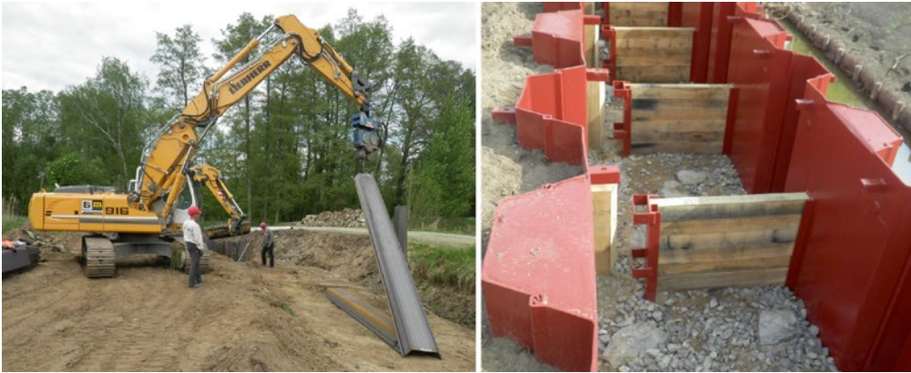
Bild 1: Vorbereitung zum Einbringen der Spundbohlen mittels Vibrationsramme (links); Schlitzpass mit Spundwänden als Tragkonstruktion (rechts)
